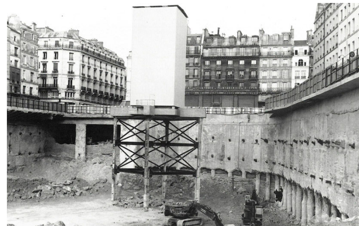
Le système d'étaie et de reprise en sous-œuvre de la fontaine pour son maintien en place pendant les travaux d'aménagement des Halles, 1974. Photographie publiée dans Les Saints-Innocents , 1990
